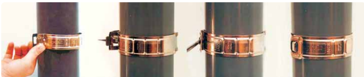
Mise en place de l'étrier
