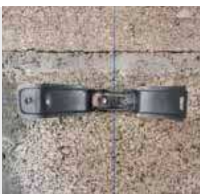
1. Mise en place de l'embase
